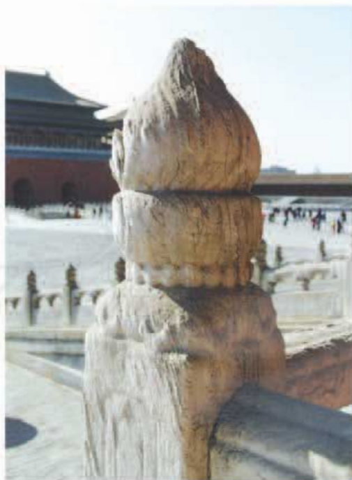
图22.4-3 被酸雨严重腐蚀的汉白玉石柱
