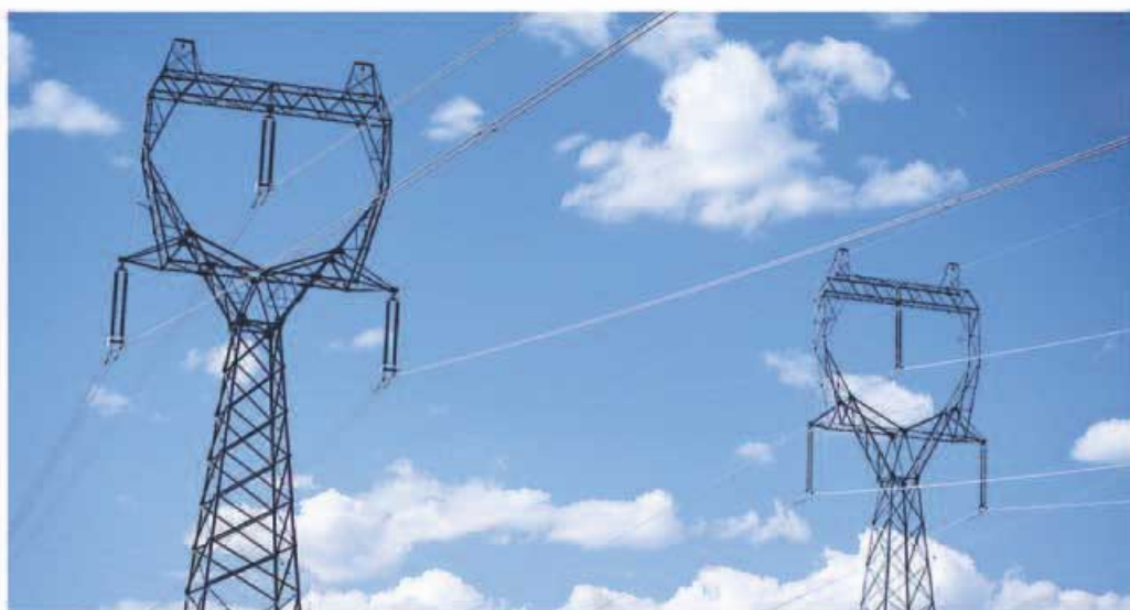
图19.3-5 高压输电铁塔最上面有两条防雷的导线
