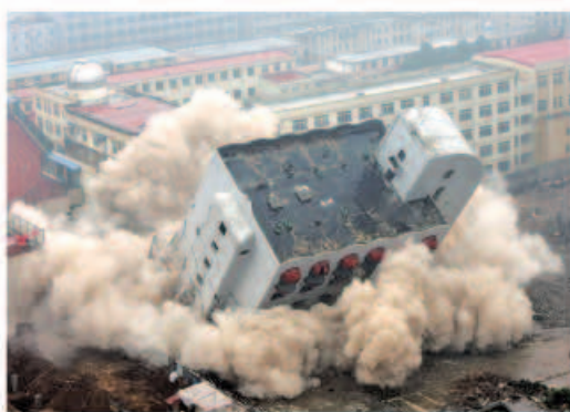
图7-17 利用炸药爆破拆除楼房
