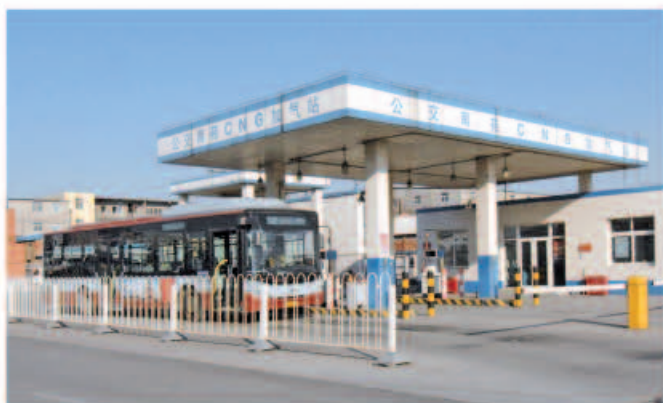
图7-37 压缩天然气汽车加气站
