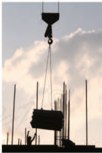
图9.2-2 起重机提升建筑材料
