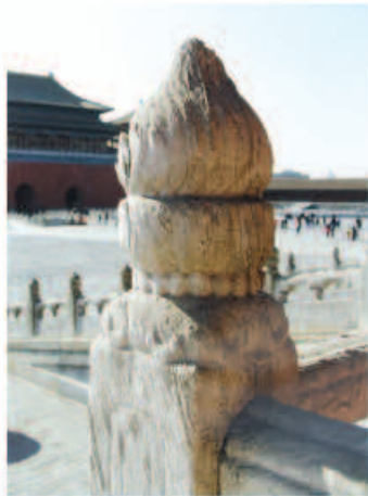
图18.4-3 被酸雨严重腐蚀的汉白玉石柱
