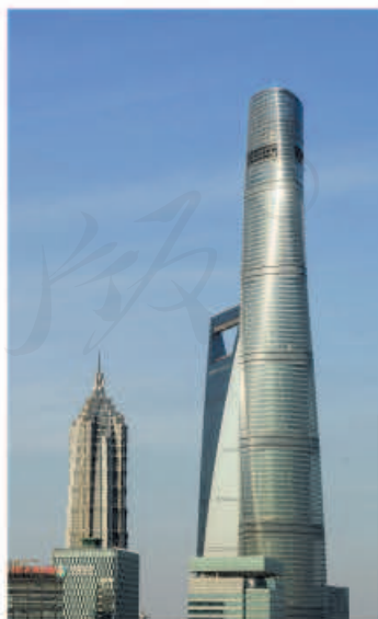
上海中心大厦 632 米
