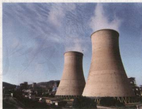
图 10.4-4 热电厂的冷凝器。烟筒似的器壁内有很多管道，来自蒸汽轮机的废气在管道内冷却。器壁的下沿与地面间留有缝隙，便于冷凝器内空气的流动，同时有冷水喷到管道上，增强冷凝效果。
