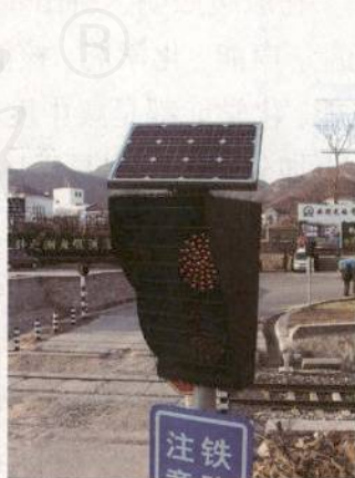
图 10.6-1 用来为无人值守的信号灯提供能源的太阳电池
