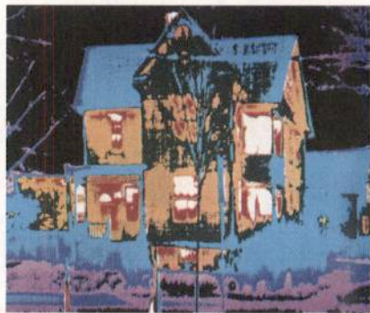
图7.10-1 一座房屋的红外照片（红外照片是不能分辨颜色的，图中的颜色是为区分不同的温度而在照片处理时加上的）。可以看出，由于取暖和使用电器，室内温度比室外高。热量散失到室外后，不能回收重新利用。
