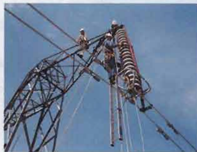
图 1.7-11 超高压带电作业的工人所穿衣服的织物中掺入了金属丝
