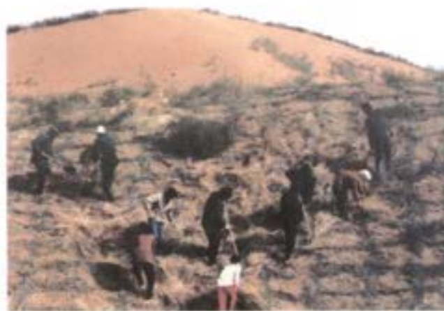
图5-8 草方格阻止沙丘移动
