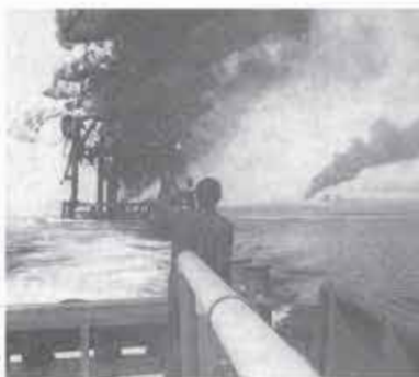
遭袭后，石油码头燃起大火
