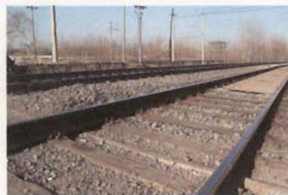
图 3-4 用锰钢 (一种合金钢) 制成的钢轨
