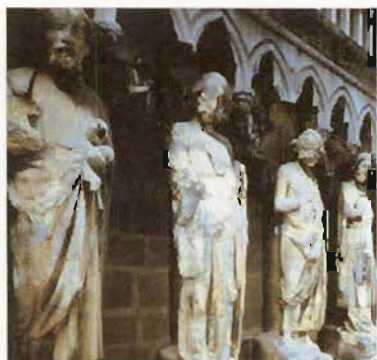
图 4-3 用大理石或石灰石制造的雕像受到酸雨的腐蚀
