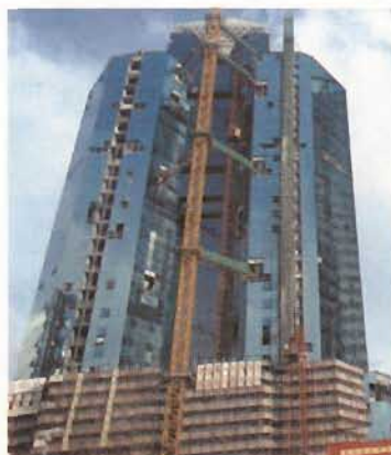
图 3-31 钢筋混凝土常用来建造高楼大厦
