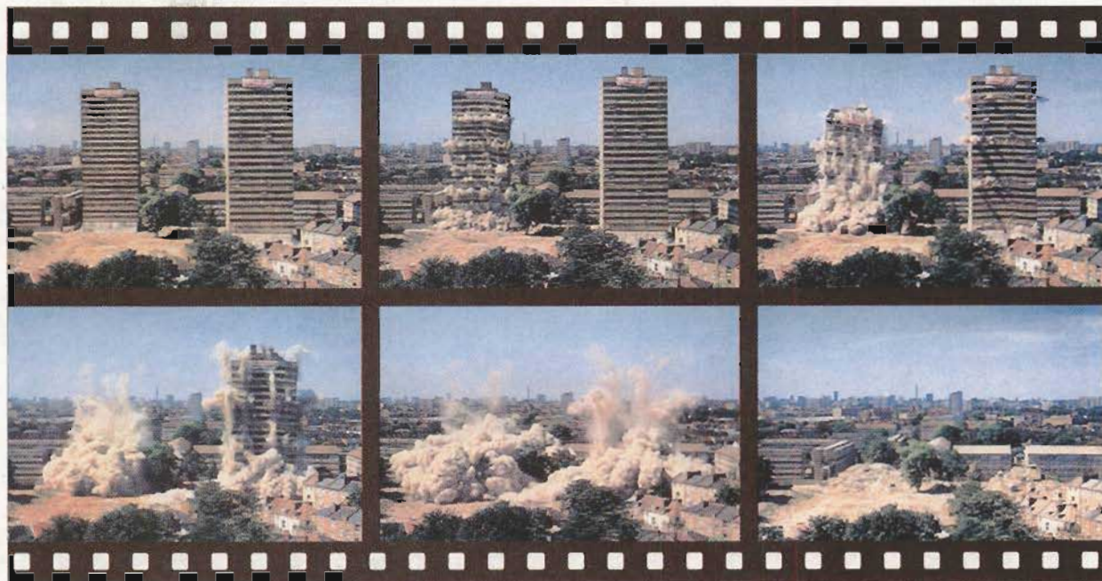
图 2-21 建筑物的定向爆破
