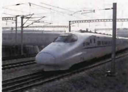
图 5.1 京津高速铁路
